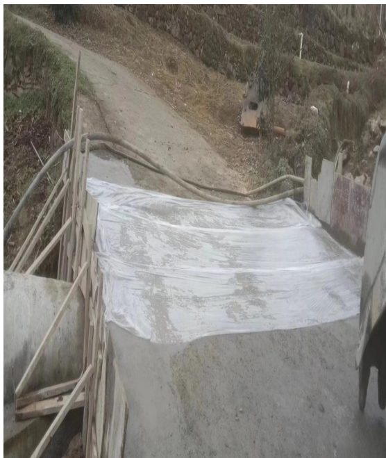
(顺河村生态宜居建设——修复公路堡坎、安装涵管)
