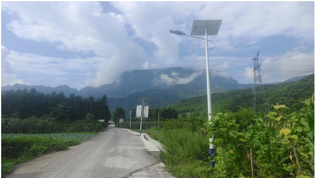
(瓦山村生态宜居建设——安装太阳能路灯)
