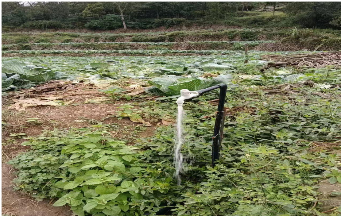
（吉星村生态宜居建设——维修引水管道）
