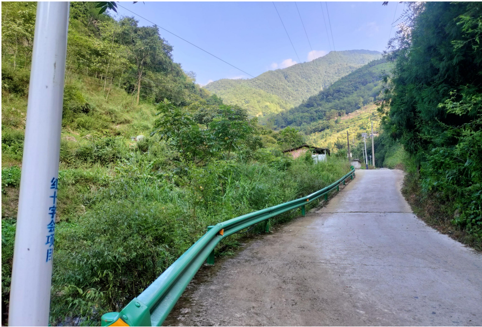
(象鼻村生态宜居建设——安装太阳能路灯)
