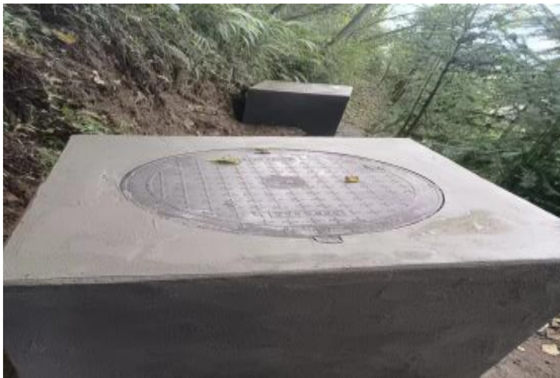
(五一村生态宜居建设——新建蓄水池)
