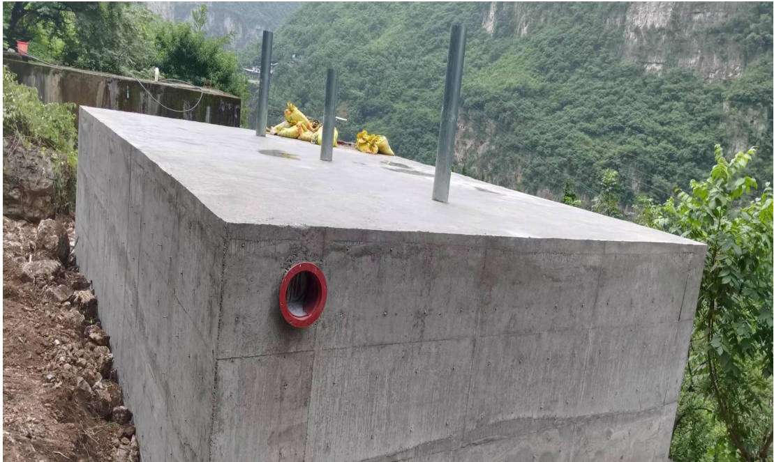
(胜利村生态宜居建设——修建蓄水池)
