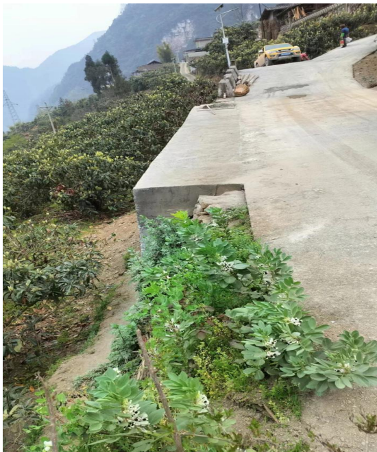
(顺河村生态宜居建设——修复公路堡坎、安装涵管)
